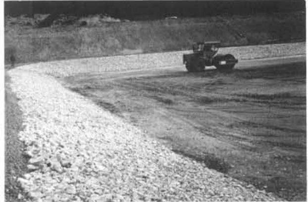
Photo 4 : Protection du talus amont par petits enrochements ; compactage du fond de bassin.
