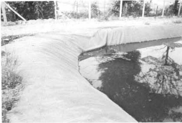
Photo 2 : Digue étanchée par une géomembrane.
