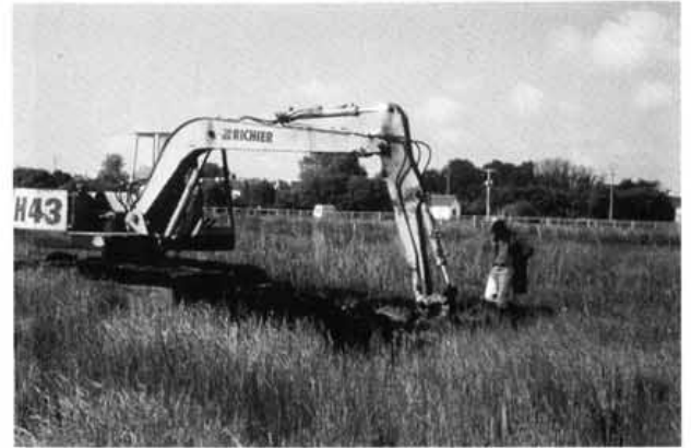
Photo 7 : Reconnaissance par pelle mécanique du site choisi.
