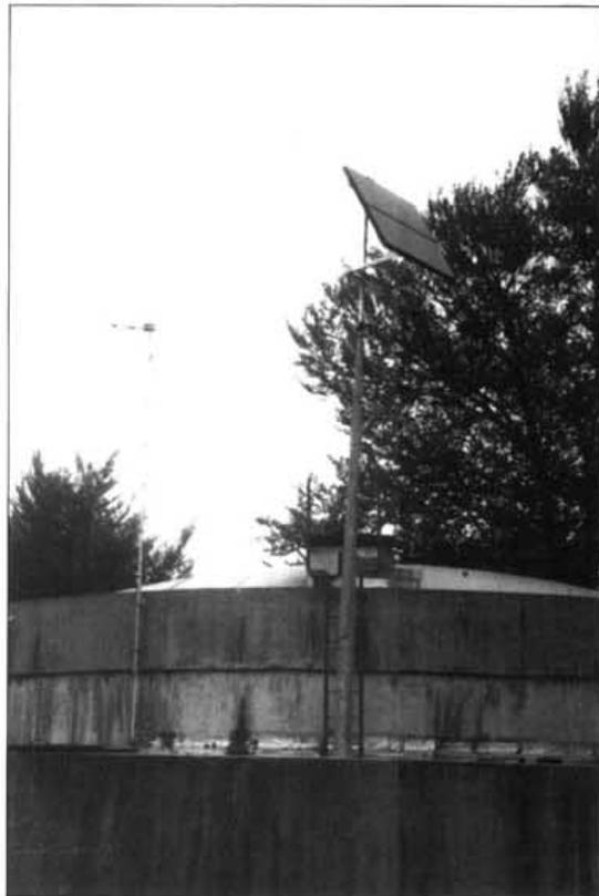
Exemple de télétransmission radio de mesure de niveau dans le département de l'Oise
