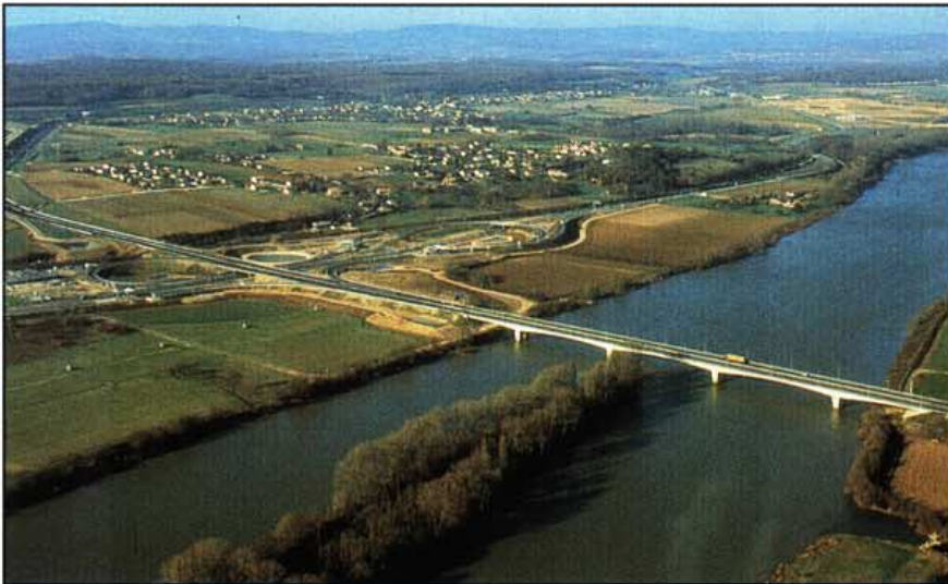
Fig. 55 : Liaison A6-A40 Diffuseur de Macon centre (photo SAPRR)
