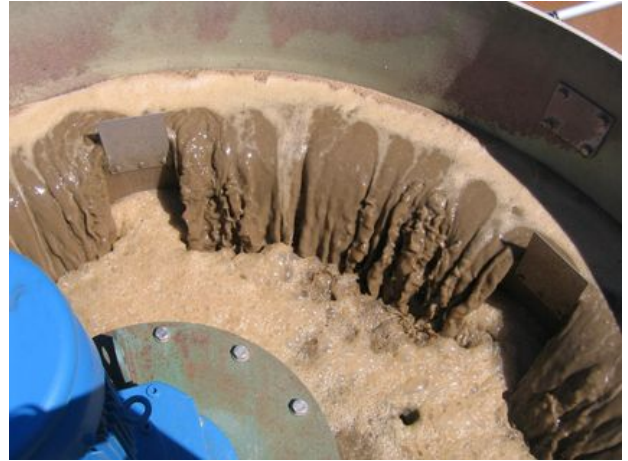
Photos 8 et 9 : Réacteur Carbofil – soufflante et chute en surface
