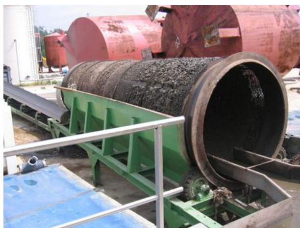
Photo 10 : Trommel du prétraitement (CTMA)
