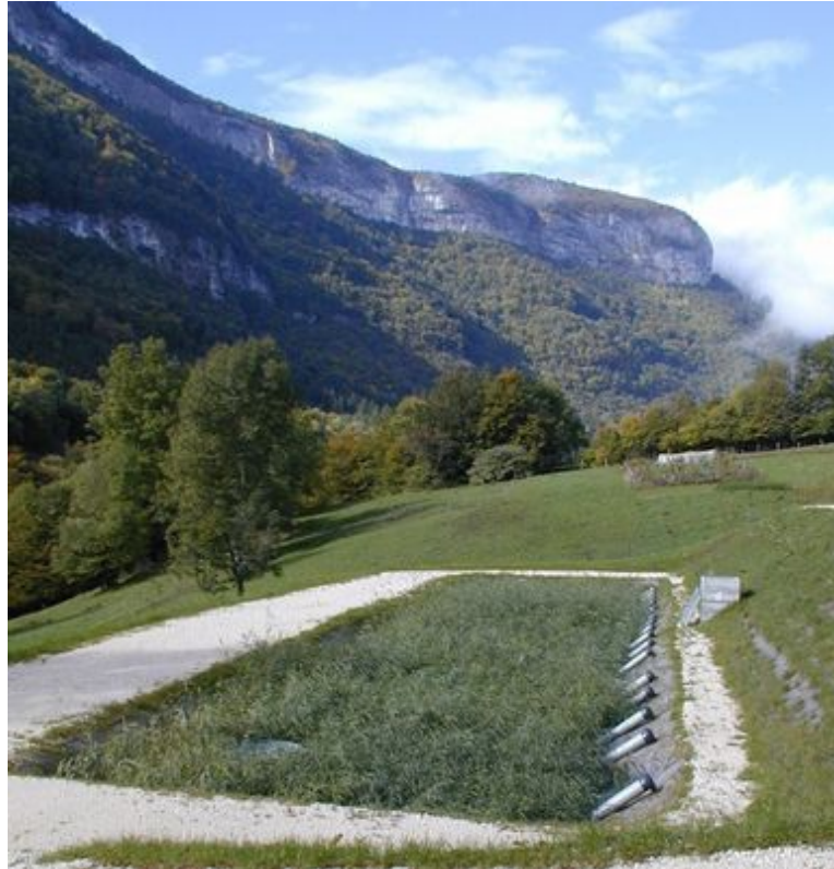
Photo 5 : Filtres plantés de roseaux
