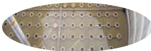
➤ Les diffuseurs doivent être relevables, si possible en plusieurs parties de manière à laisser en fonctionnement suffisamment de potentiel d'aération et de brassage durant les brèves périodes pendant lesquelles une raquette de diffuseurs est mise hors service.
