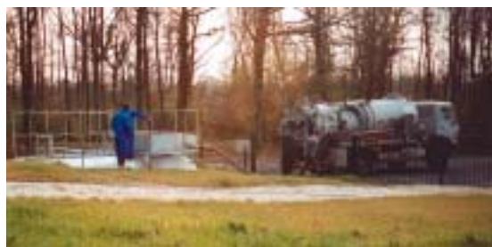
Photo 2 – Dépotage de matières de vidange à Beaumont-la-Ronce
