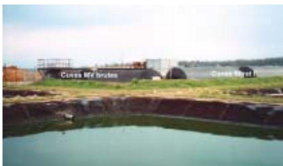
Photo 6 – Aperçu des installations de traitement primaire à La Celle-Guénand
