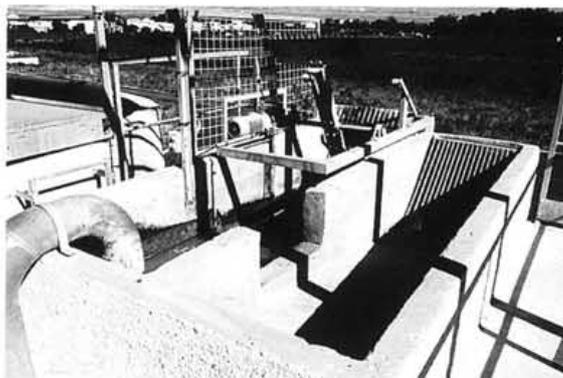
Photo 8 : Dégrillage de secours (SATESE 34)
