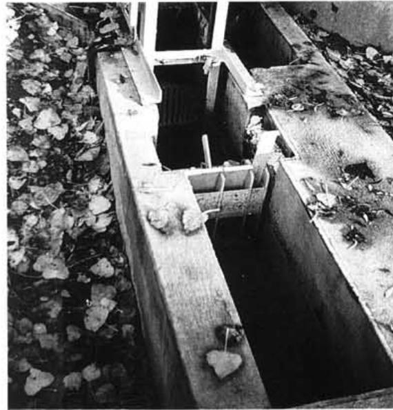
Photo 5 : Protection hydraulique par module à masque (SATESE 44)
