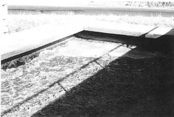
Photo 14 : Mur extérieur du bassin : revanche + acrotère (SATESE 37)
