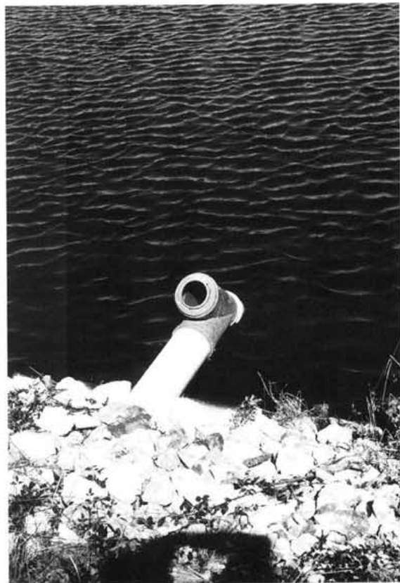
Photo 24 : Dispositif de liaison entre lagunes (SATESE 34)
