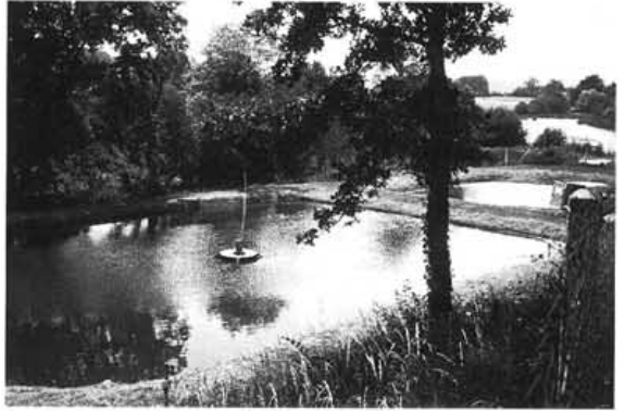
Photo 25 : Bassin de lagunage aéré (SATESE 37)
