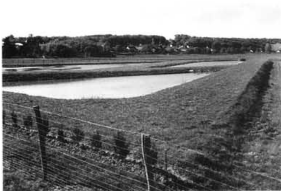
Photo 23 : Bassins de lagunage naturel (SATESE 41)
