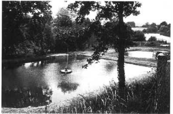
Photo 25 : Bassin de lagunage aéré (SATESE 37)
