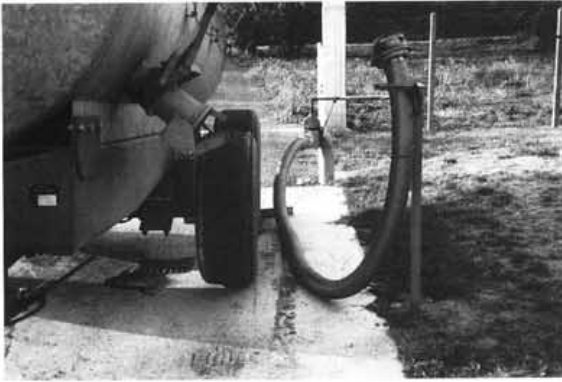
Photo 21 : Poste de reprise des boues par tonne à lisier (SATESE 37)
