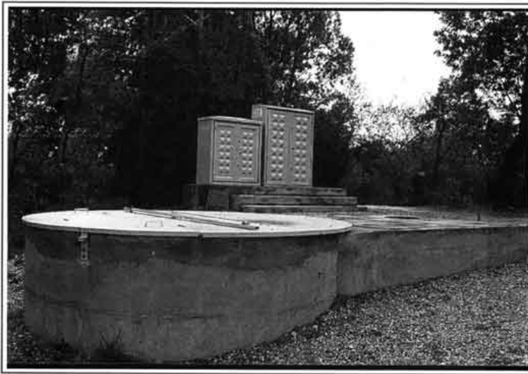
Miribel et Neyron : vue extérieure d'un poste
