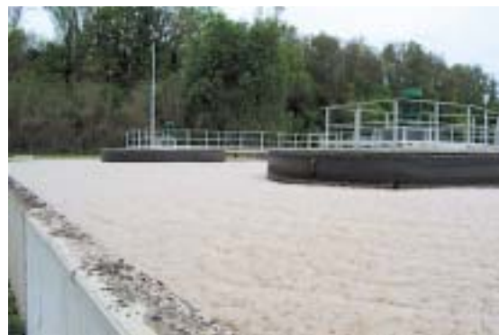
Figure 6 – Mousse biologique en surface de bassin d'aération
