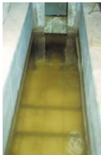
Figure 16 – Sortie station – rejet « chargé » suite à des pertes de MES du clarificateur
