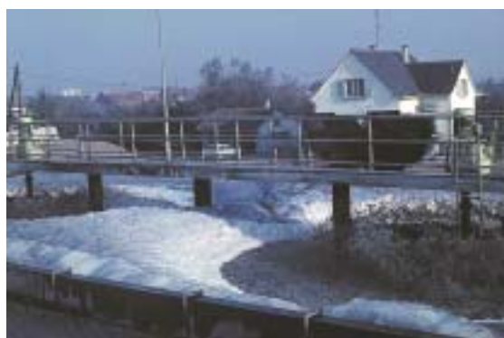
Figure 8 – Mousse blanche de détergents* en surface de bassin d'aération
