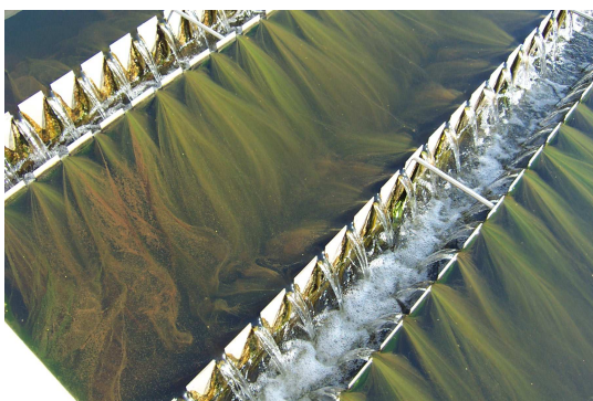
Photos – Développement d'algues en surface du décanteur lamellaire
