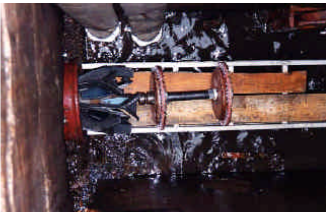
Photographie n°7. Raclage mécanique : le nettoyage 3R (source AXEO)
