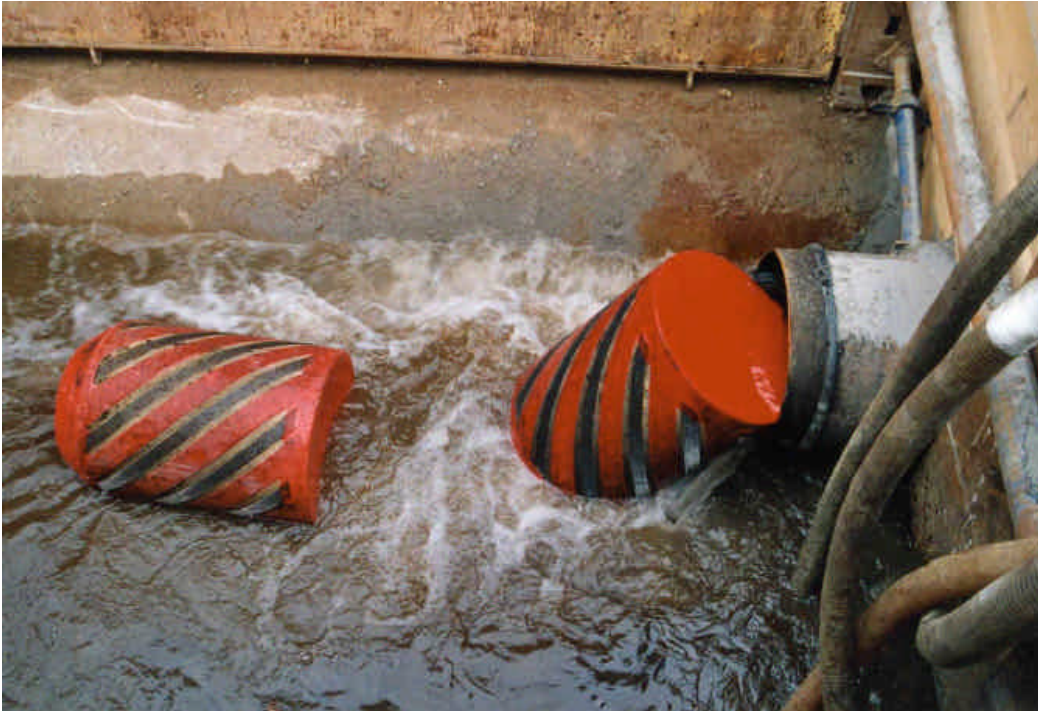
Photographie n°5. Racleur souple (Source AXEO)
