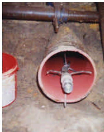
Cette technique non structurante a pour objet l'application d'un revêtement interne à 1 mm d'épaisseur à base de résine époxy.
