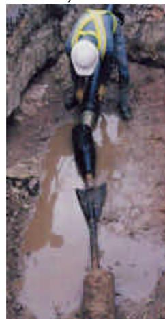
Cette technique consiste en un remplacement d'une ancienne canalisation par une nouvelle conduite en PVC ou polyéthylène d'un diamètre supérieur ou égal.
