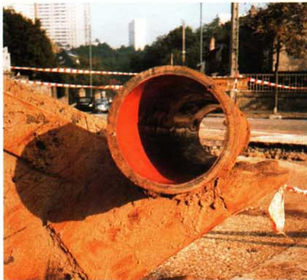
Etat après revêtement (photo NANCIE)
